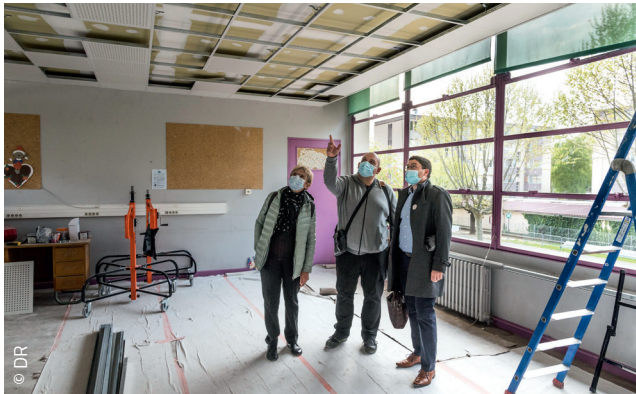
École Paul Langevin, reconstruction des faux plafonds.
