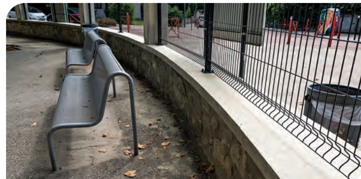
École élémentaire Ancienne mairie - Réfection du mur d'enceinte
