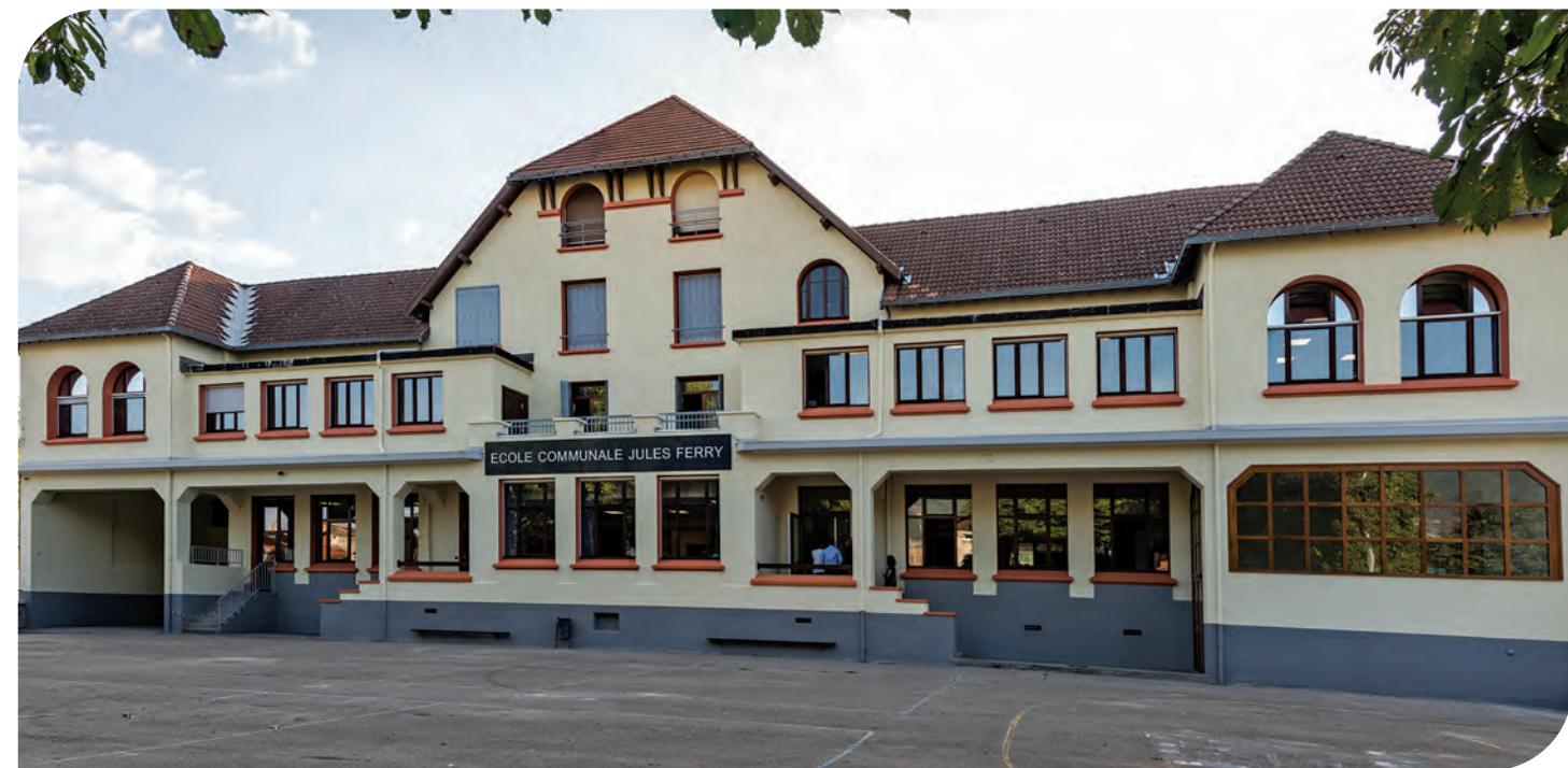
École primaire Jules Ferry - Rénovation de la façade
